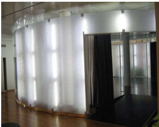
Museumseinrichtung; hinterleuchtete Wandverkleidung/ Aménagement de musée à éclairage indirect
